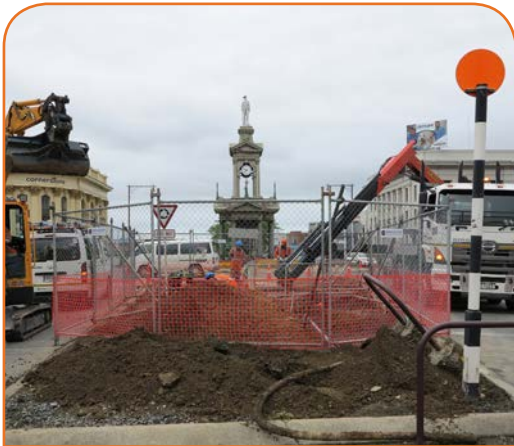
Substation 511 (Troopers Memorial).
